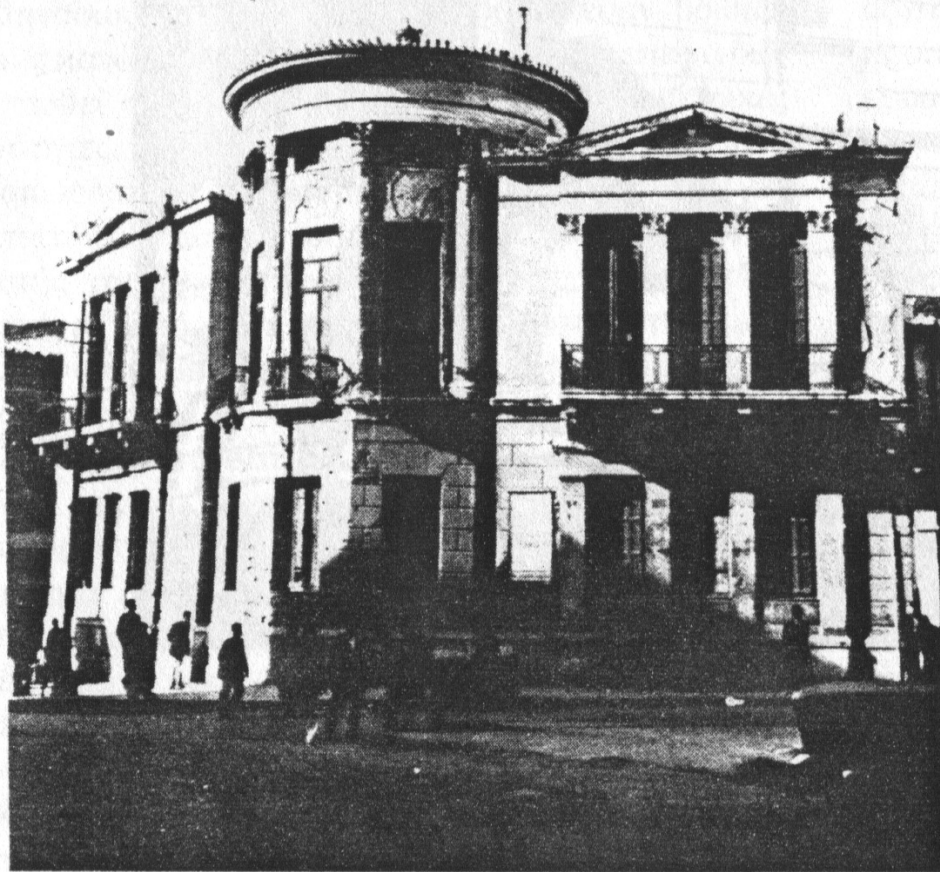
Εικ. 96 Ανορθόδοξη λύση άρθρωσης των κτηριακών όγκων. Οικία Τετενέ (ή Τσοποτού), στις οδούς Πειραιώς, Γερατίου, Μενάνδρου - κατεδαφισμένη.
